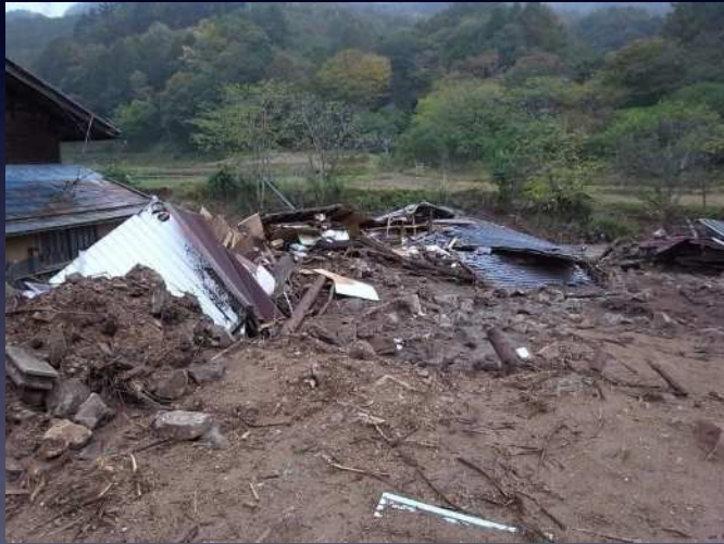
令和元年度台風19号災害 土石流発生による家屋の倒壊：佐久穂町高山地区
